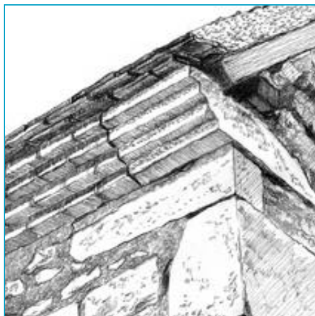
Détail de corniche en brique
