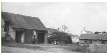
En 1936, la façade sur cour de la même grange.
