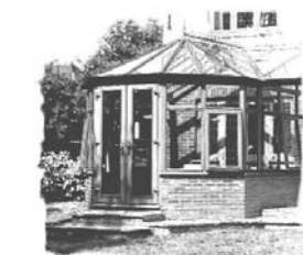
Véranda aux murs et toit vitrés, à éviter en raison de l'effet de serre.
