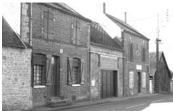
Avant : baie dénaturée (partiellement remplie en parpaings).
