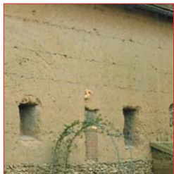
Mur de ferme et en haut à droite mur de clôture en bauge.
