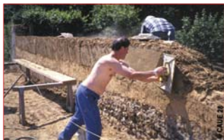
Chantier de reconstitution d'un mur en bauge : talochage de la deuxième levée.
