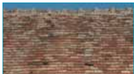
Le faitage des toitures en tuile.
