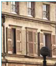
Enduit plâtre et chaux sur une ossature en pan de bois. Châteauneuf-en-Thymerais.
