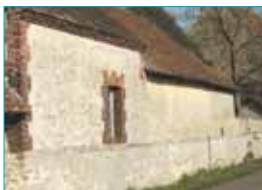
Enduit à pierre vue au premier plan de la construction, et enduit couvrant au second plan. Saint-Ange et Torçay.
