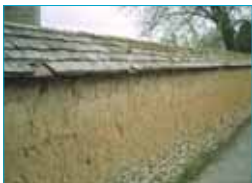
Mur en terre crue, soubassement silex. Broué.
