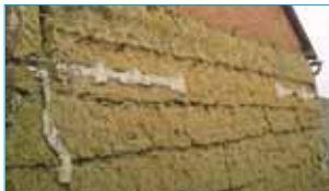
Mur en bauge. Broué.
