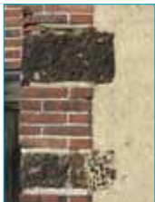
Maçonnerie en pierre de grison et brique.
