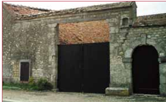
Porche en maçonnerie à Levesville-la-Chenard avec un linteau droit et une porte piétonne accolée.
