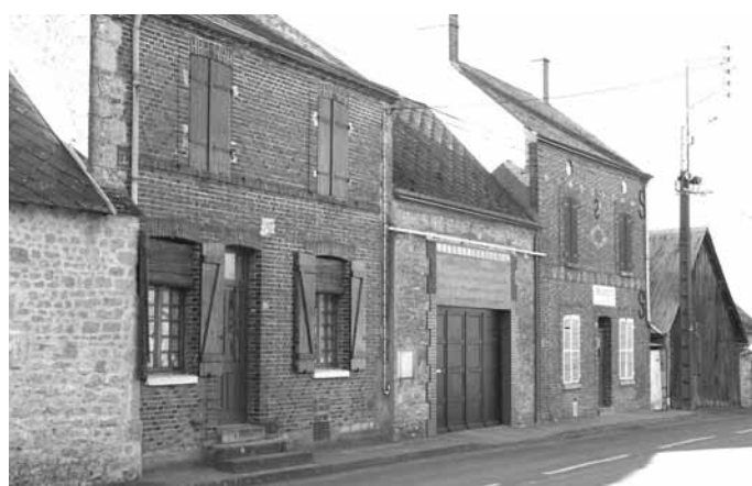
Avant : baie dénaturée (partiellement remplie en parpaings).
