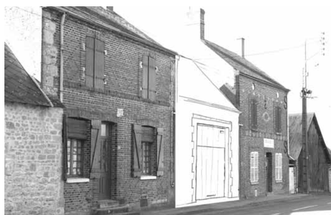
Après : mise en valeur de la baie
