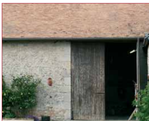
Moellons* calcaires à "pierre vue" et pierre calcaire taillée en encadrement de la baie.
