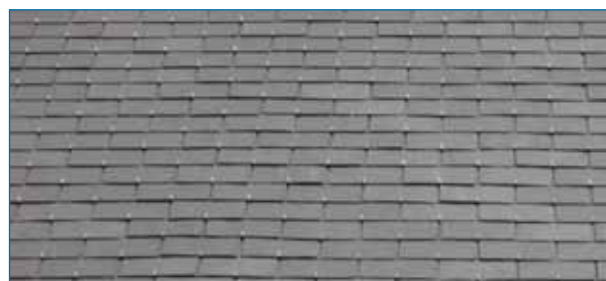
Toiture en ardoises.
