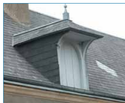
Lucarne* sur le versant du toit, à croupe débordante, charpentée, dont les jouées* sont recouvertes d'ardoises.
