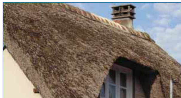
Toiture en Rouches*.
