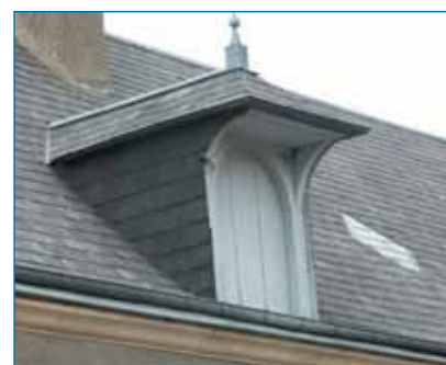
Lucarne* sur le versant du toit, à croupe débordante, charpentée, dont les jouées* sont recouvertes d'ardoises.
