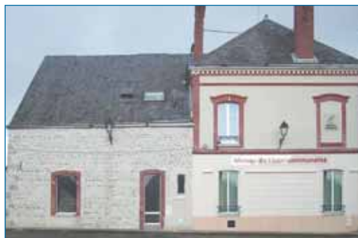
Enduit* à pierre vue* à gauche et enduit* couvrant à droite. Maison de l'Intercommunalité. Voves.
