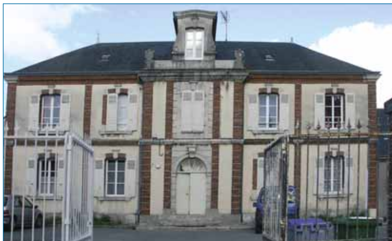
La brique est utilisée pour réaliser des éléments ponctuels des constructions traditionnelles : chaînes d'angle*, corniche* et bandeau ... Voves.
