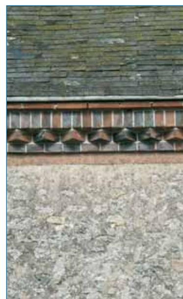
Corniche* briques et maçonnerie de moellons* calcaires enduite. Hameau de Vovette.
