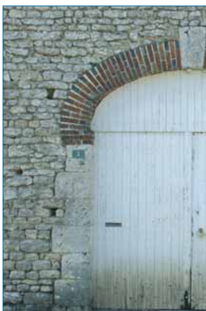
Encadrement de baie brique et pierre de taille. Hameau de Vovette.
