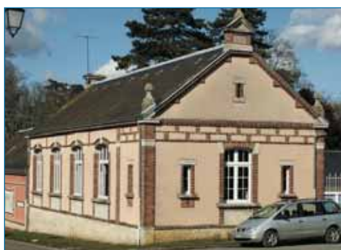
Maisons en maçonnerie de calcaire enduite, avec une modénature* en brique. En haut à Janville et ci-dessus à Béville-le-Comte.
