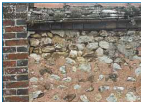
Mur de clôture en maçonnerie mixte de silex enduite à pierre vue* et briques. Montainville.
