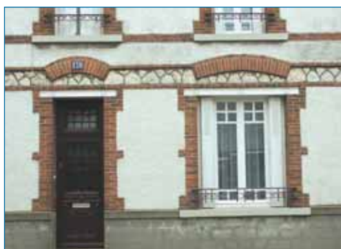
Maçonnerie mixte de moellons* calcaires enduite et pour la modénature* : briques et moellons*. Toury.
