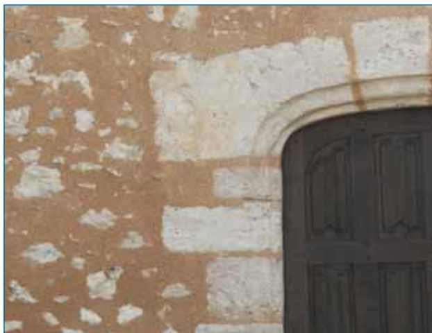
Encadrement de baie en pierre de taille et moellons* calcaires enduits* à pierre vue*. Roinville-sous-Auneau.
