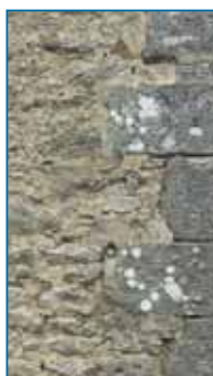
Chaîne d'angle* en pierre de taille appareillée*. Villars.
