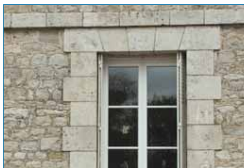
Encadrement de baie et bandeau en pierre de taille. Bazoches-en-Dunois.
