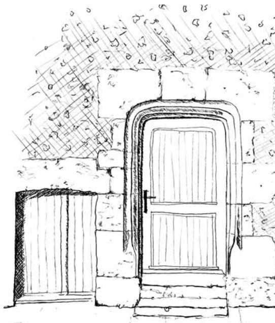
Maçonnerie de moellons* enduits* à pierre vue* et encadrement de baie en pierre de taille appareillée*. Santeuil.
