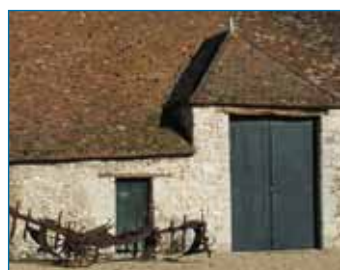
Tuiles en terre cuite, moellons* calcaires, chêne et châtaignier.
